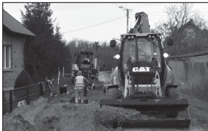
Począwszy od grudnia ubiegłego roku trwa budowa kanalizacji sanitarnej w Dłużynie
